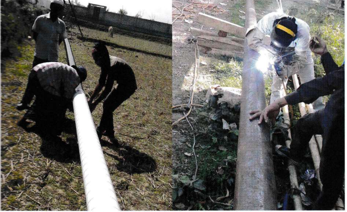
সিলেট গ্যাস ট্রান্সমিশন নেটওয়ার্ক আপগ্রেডেশন প্রজেক্টের আওতায় ছাতক ও জুড়ি অঞ্চলে পাইপলাইন নির্মাণ কাজ
